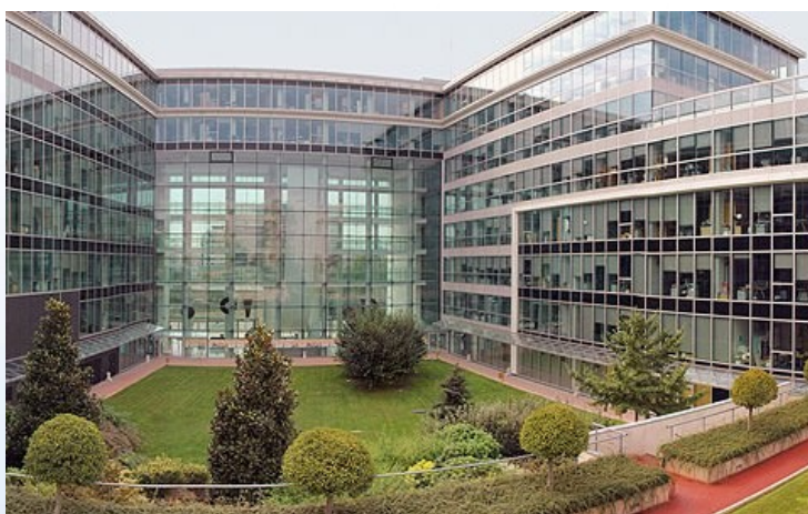
Immeuble Rives de Bercy CCF - Charenton (94)
