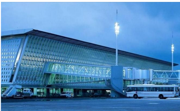
Aéroport Guadeloupe - Pôle Caraïbes
